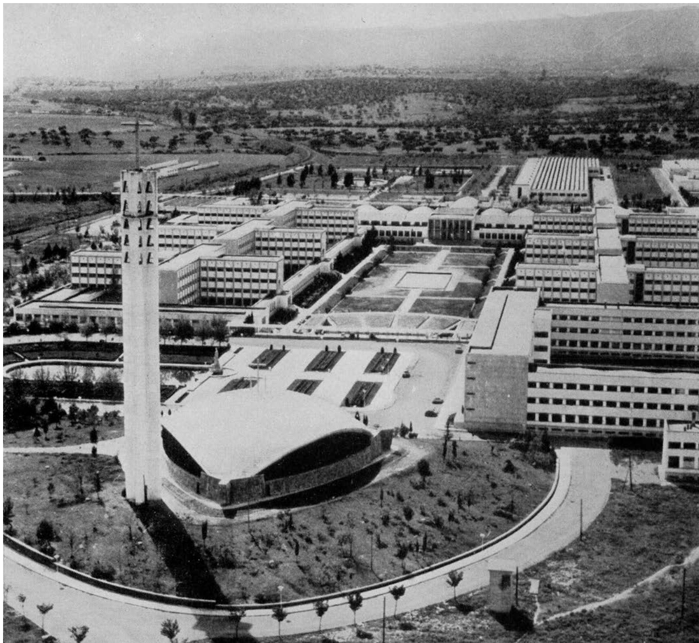
Figura 5. Vista aérea general de la Universidad Laboral de Córdoba. Fotografía de época. Sus ordenación, en base a organizaciones de pabellones independientes que albergan los distintos usos, atienden a los presupuestos planteados por la Ville Radieuse de Le Corbusier, 1930.
