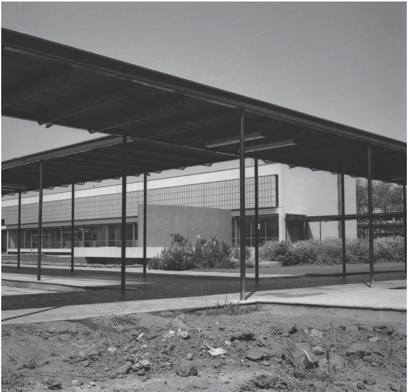
Circulación de tercer orden. Vista hacia la fachada Este del edificio Sur de Administración. Fuente: Archivo de Documentación Gráfica y Audiovisual de la Universidad de Santiago de Chile.
