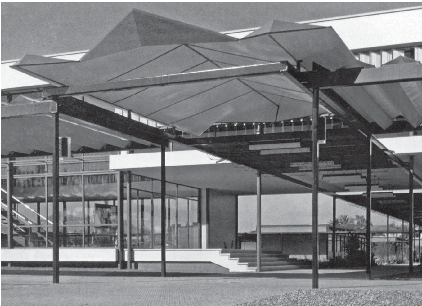
Marquesina de cabecera de la circulación de segundo orden que atraviesa el porche del edificio Sur de Administración. Fuente: CASTILLO, Fernando. Lecciones del tiempo vivido . Santiago de Chile: Catalonia, 2008: p. 53.
