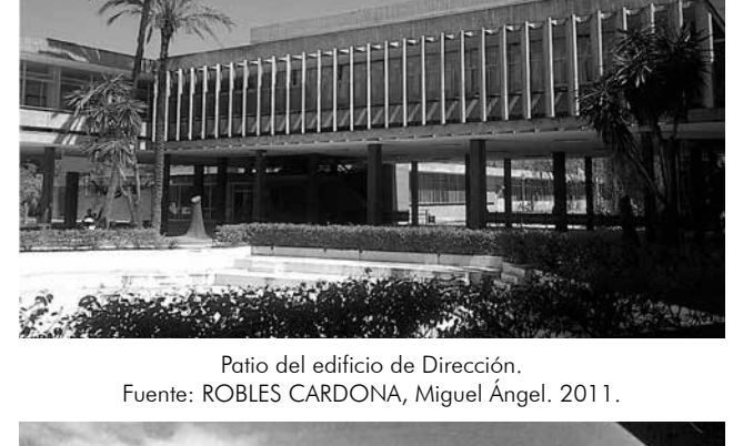
Patio del edificio de Dirección. Fuente: ROBLES CARDONA, Miguel Ángel. 2011.
