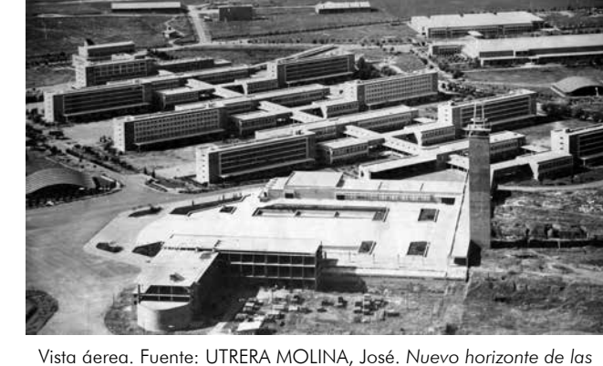
Vista aérea. Fuente: UTRERA MOLINA, José. Nuevo horizonte de las Universidades Laborales. Madrid: Ministerio de Trabajo, 1970.
