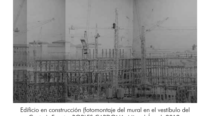
Edificio en construcción (montaje del mural en el vestíbulo del Centro). Fuente: ROBLES CARDONA, Miguel Ángel. 2012.
