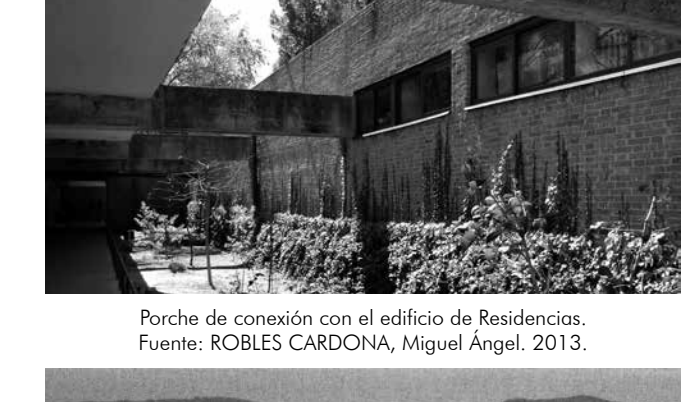
Porche de conexión con el edificio de Residencias. Fuente: ROBLES CARDONA, Miguel Ángel. 2013.
